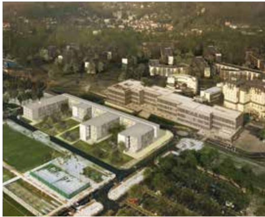
Vue aérienne bâtiment neuf
